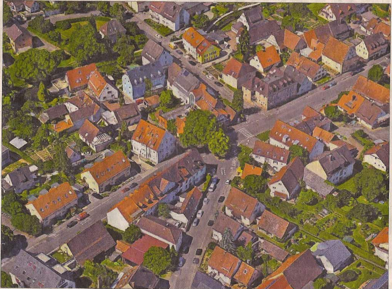
Die Umgestaltung der Einmündung der Terlaner Straße (unten) in die Andreas-Hofer-Straße ist ein Wunsch der St. Georgener. Die Verwirklichung lässt aber auf sich warten.
